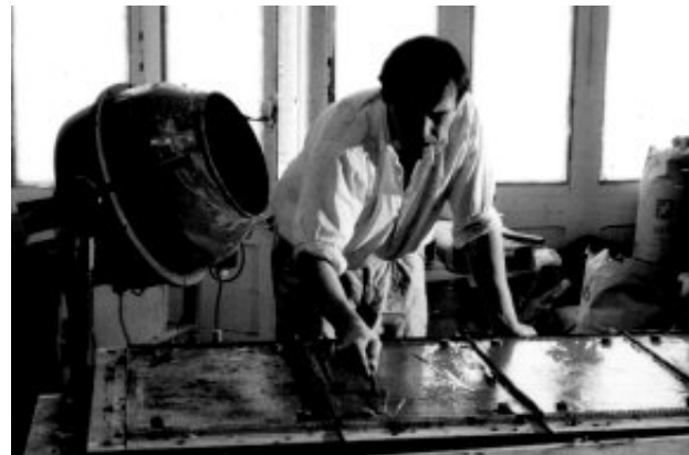
Fig. 3 : Coulée de béton. P.-M. de Biasi, lissage de quatre dalles en ligne
