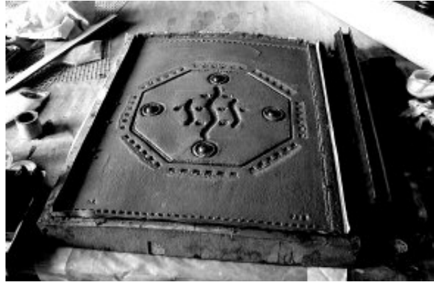
Fig. 5 : Dalle formée. Béton en prise, avec sa protection de kraft dans le moule
